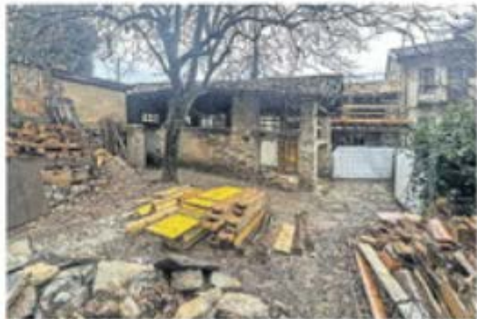
Cantiere in corso.
